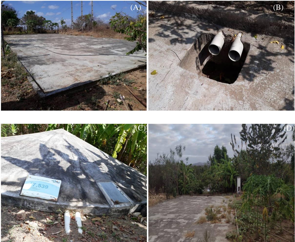
Figura 7. Cisterna calçada: calçada (A), decantador (B), cisterna calçada vista de perto (C) e cisterna + calçada (D).
