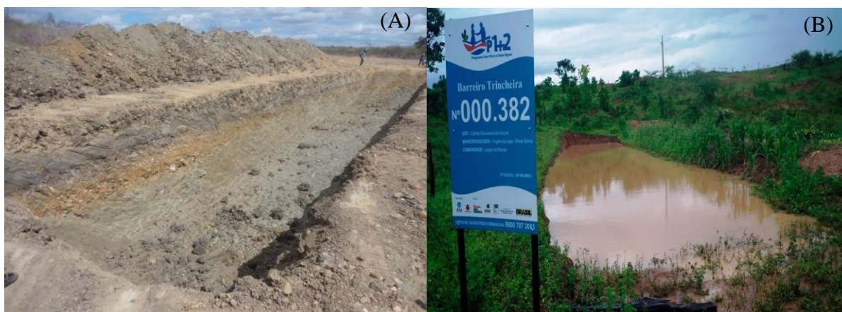
Figura 14. Barreiro trincheira finalizado (A) e barreiro trincheira cheio (B).
