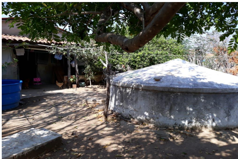
Figura 5. Cisterna de 16.000 litros construída próxima a cozinha de uma residência do assentamento Palmares I, em Crateús – CE.
