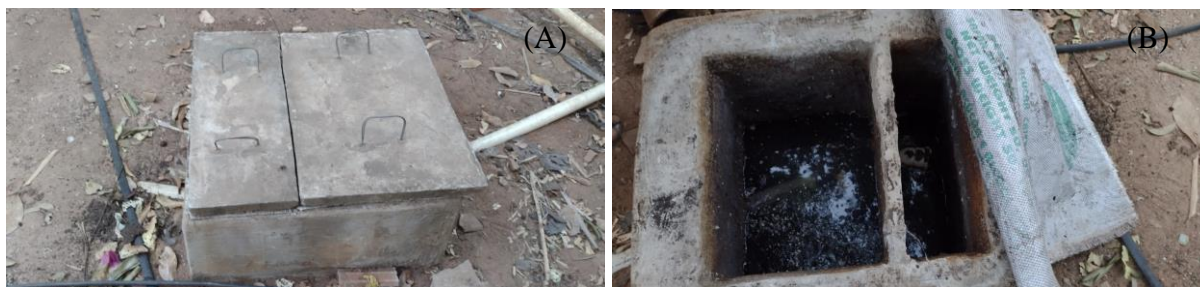
Figura 20. Vista superior da caixa de gordura do sistema bioágua familiar (A) e caixa de gordura destampada (B).
