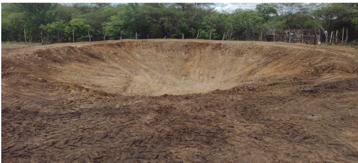
Figura 16. Barraginha de contenção de enxurrada em propriedade rural do município de Simões – PI.
