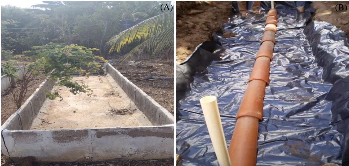
Figura 29. Canteiro econômico construído com placas de cimento pré-moldadas (A) e com lona plástica (B).
