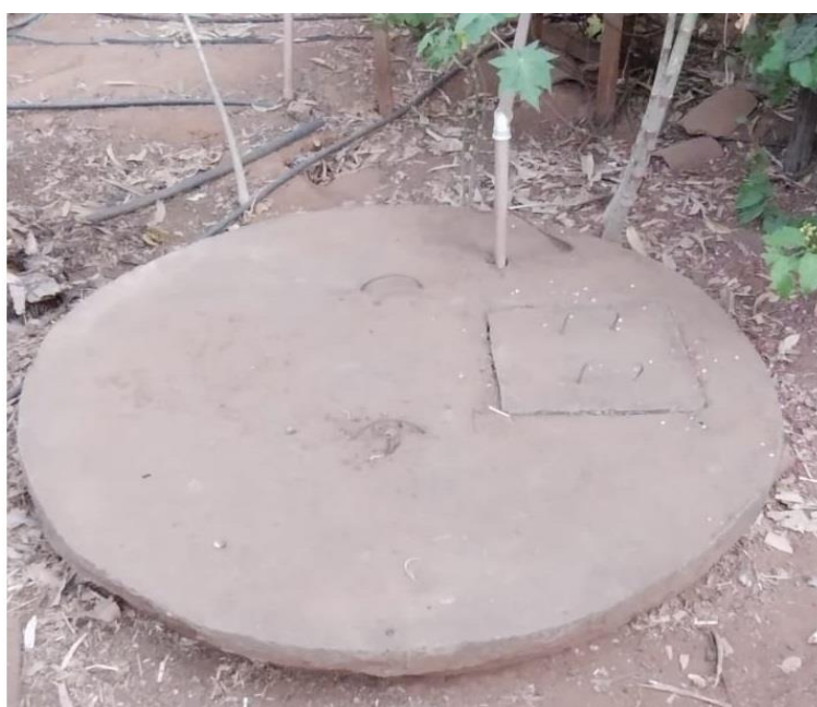
Figura 23. Vista superior do tanque de reuso do sistema bioágua familiar.
