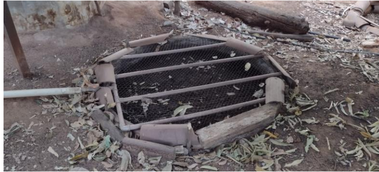
Figura 21. Vista superior do filtro biológico do sistema bioágua familiar.
