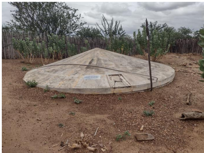
Figura 45. Cisterna de enxurrada utilizada para armazenar água para consumo humano, no assentamento Liolândia, município de Independência – CE.
