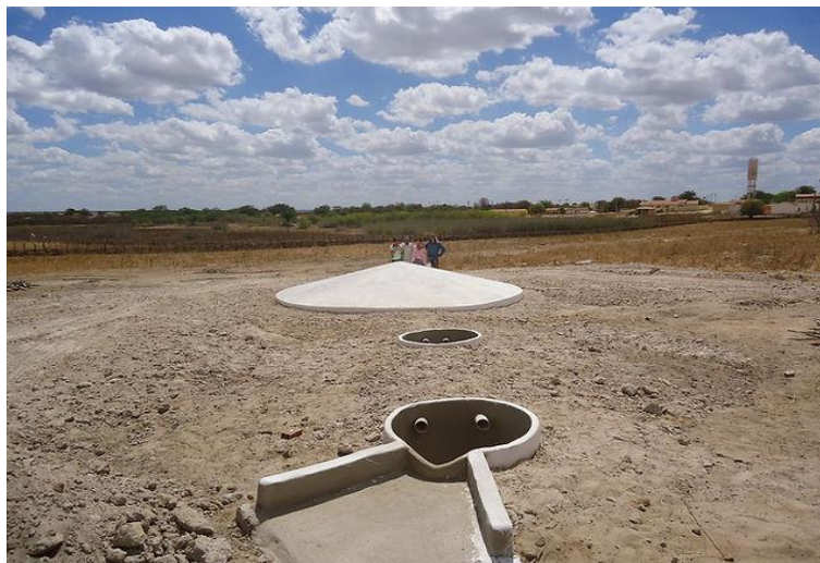
Figura 8. Vista de uma cisterna de enxurrada.
