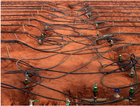
Figura 2. Instalação do sistema de irrigação.
