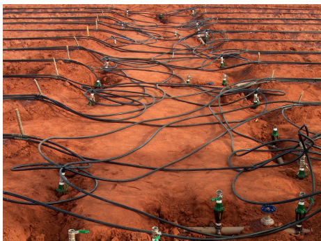
Figura 2. Instalação do sistema de irrigação.
